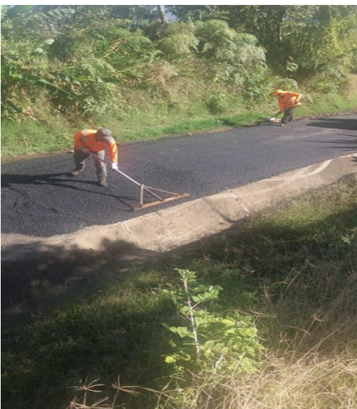
Bacheo con mezcla asfáltica
