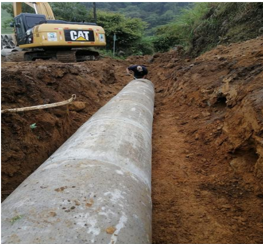
Colocación de pasos de agua
