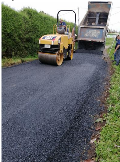
Bacheo con mezcla asfáltica colocada por la UTGVM
