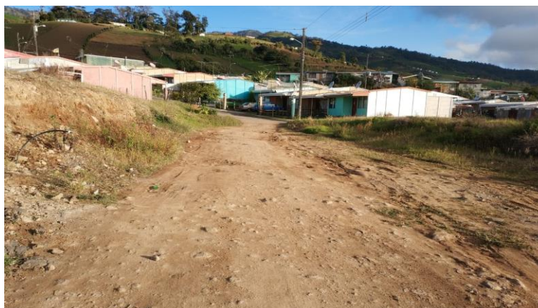
Imagen 2. Tramo faltante en calle 2.
